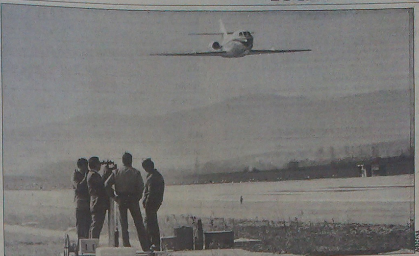
En la foto retrospectiva aparece el avión laboratorio que en marzo de 1.983 comprobó las condiciones técnicas del aeropuerto de Foronda, de cara a su homologación como aeropuerto de categoría dos.
